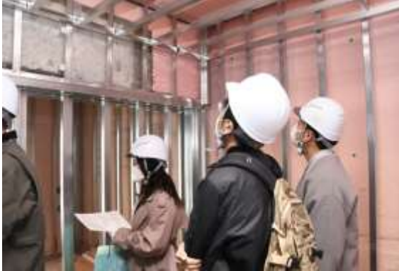
住居部 断熱材の施工を確認
