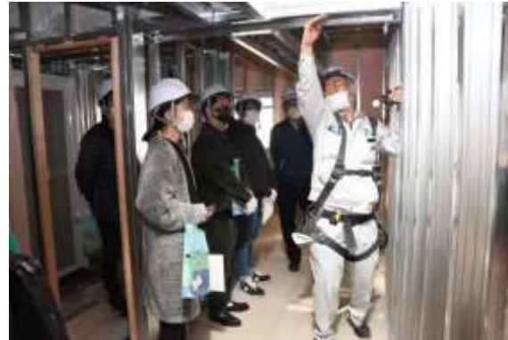
LGS 建込を確認（施工業者の説明を熱心に聞く学生）
