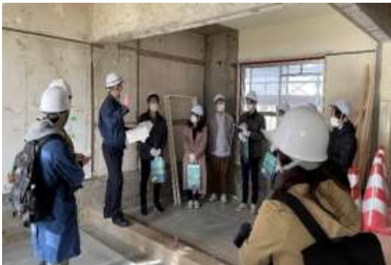
共用部 現状の躯体状況及び今後の仕上げを確認
