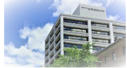
神奈川県住宅供給公社ビル （大規模改修工事中）
