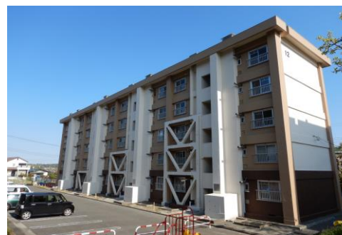
二宮団地 耐震ブレース設置
