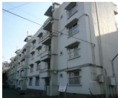
改修前：桜ヶ丘共同住宅
