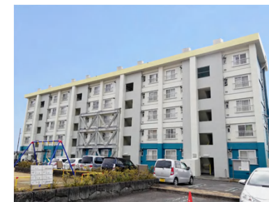
▲耐震改修工事 (二宮第6団地:二宮町)
