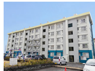
▲耐震改修工事 (二宮第6団地:二宮町)
