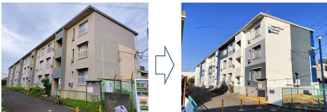
▲外壁塗装工事前(写真左)・工事後(写真右)／外壁塗装での色彩デザイン取組事例 (相模原高根団地:相模原市中央区)
