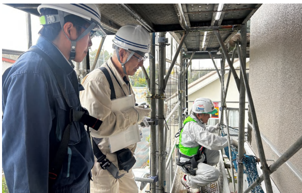
▲外断熱改修工事 (相模原高根団地:相模原市中央区)
